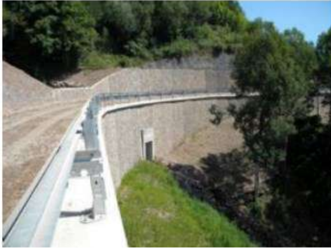
ბეტონის კონსოლური საყრდენი კედელი სურათი 4-14. დამცავი კედლები
